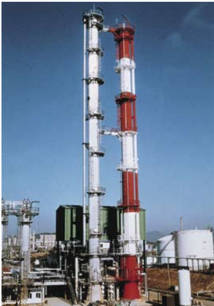
Установка получения 1-бутена с использованием тепловых насосов
